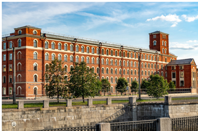
Наб. Обводного канала, д. 60
